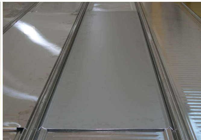
Photovoltaïque collé sur adaptateur intégré
