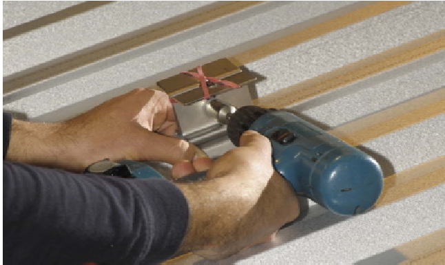
Bild 9.1: Befestigung Edelstahlklemme
