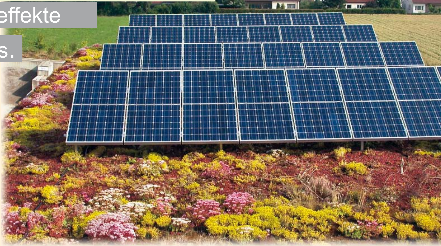
Dach der Firma Pro Natur in Metzingen
