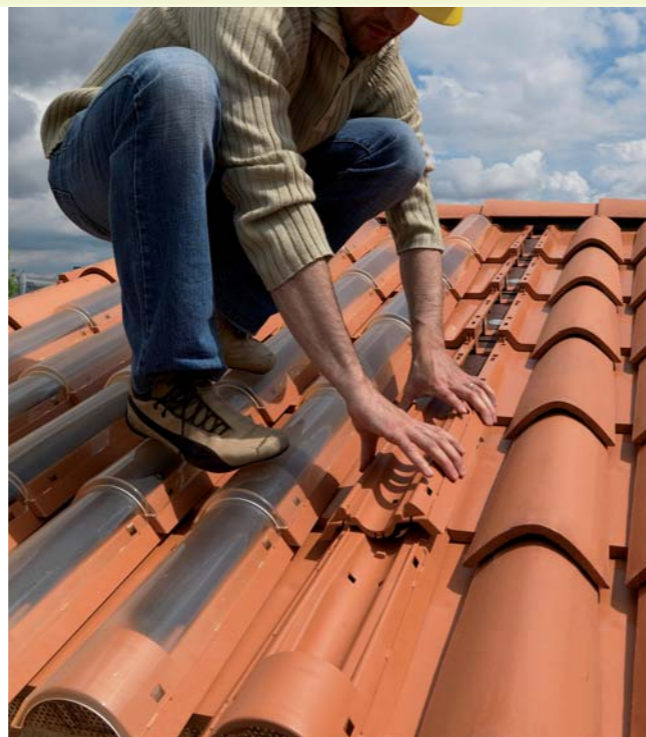
La posa del corpo tegola Easy avviene mediante incastri
