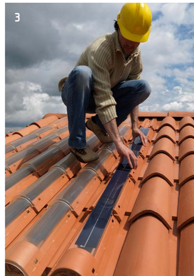
Innesto del modulo Easy sulla fila di tegole
