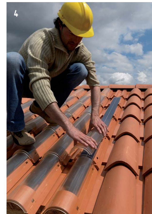
Protezione del modulo con gli appositi vetri di copertura
