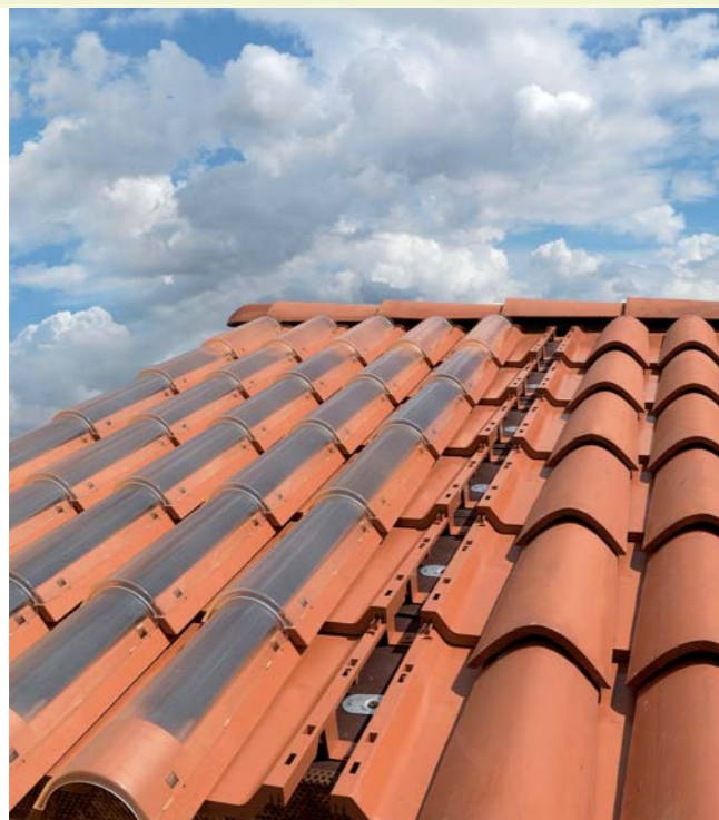
Il tetto predisposto per l'installazione
